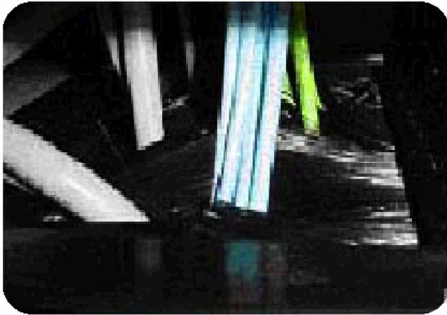
La découpe des dalles, nécessaire au passage des câbles doit être réduite à son strict minimum afin de maintenir une pression de l'air suffisante sous le faux plancher et ainsi ne pas diminuer la sortie d'air au niveau des dalles ventilées. S'il est nécessaire de s'assurer du passage de l'air frais sur le devant de la baie les orifices provoqués par la découpe des dalles seront obstrués une fois les câbles passés afin de maintenir une pression maximale sous le faux plancher.
