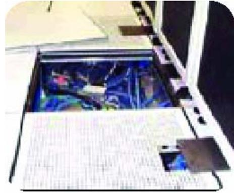
Le design des dalles ventilées varie allant de 400 CFM à 1000 CFM. Les dalles perforées ont une capacité CFM moindre que les dalles ventilées ajustables métalliques qu'on utilise le plus souvent pour équilibrer le circuit d'air à l'intérieur des suites.
